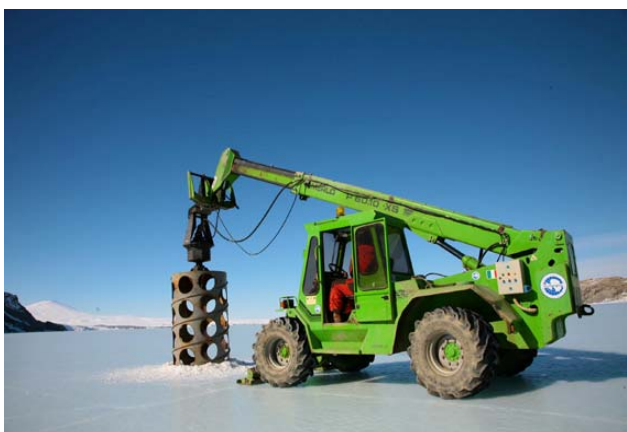
Fig. 3 - Foro in realizzazione
