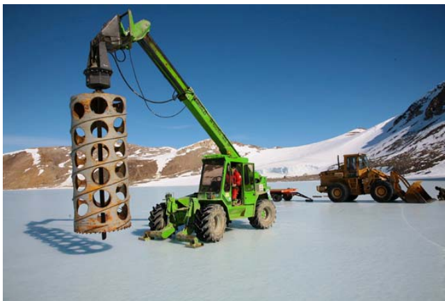
Fig. 2 - Il carotiere applicato ad un comune mezzo di sollevamento
