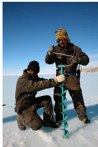
Realizzazione foro ispettivo
